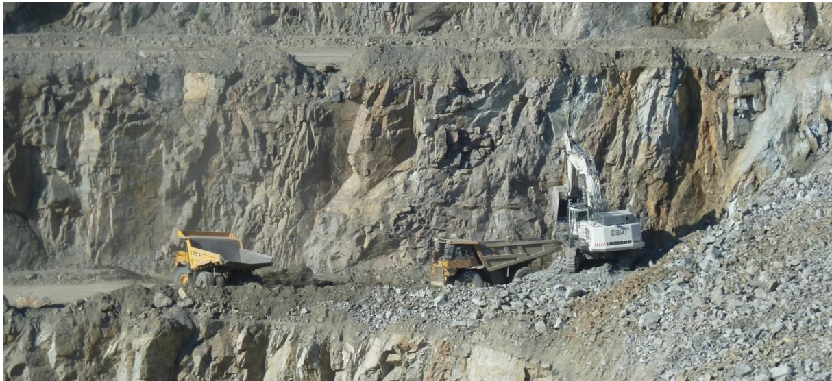
Figure 4 - Extraction du matériau en fond d'excavation
